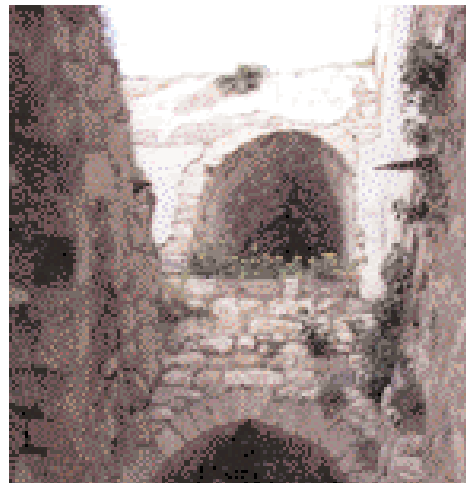
داخل برج المدخل. Inside the entrance tower.
